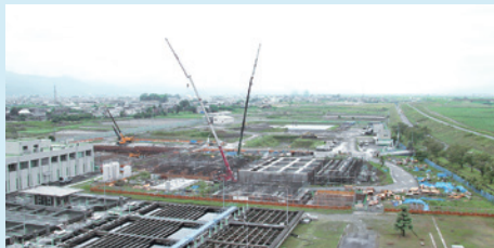
浄水施設建設工事
