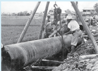
西の丸送水管新設工事
