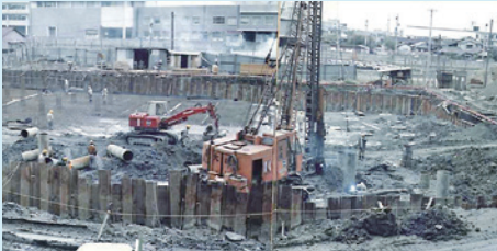
西の丸配水場調整池建設
