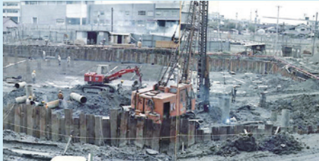
西の丸配水場調整池建設
