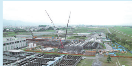
浄水施設建設工事
