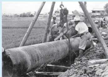
西の丸送水管新設工事
