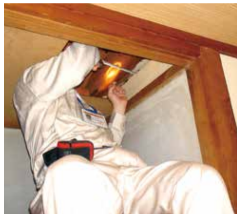
▲耐震診断の様子
