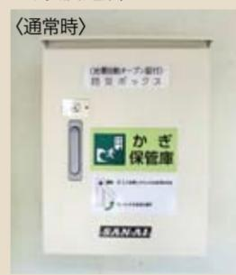
揺れを感知すると自動解錠するもので、これにより、中に入っている校舎などの鍵を使って、津波からの避難に有効な階へ行くことができます。保管庫には、▶施設入口など(解放時)の鍵▶施設の見取り図▶手動式懐中電灯▶パール(破壊器具)——などが入っています。
