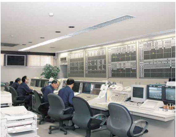
徳島市消防局の通信指令室
