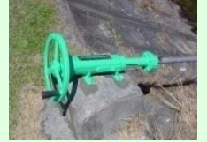
ゲート、バルブの更新
