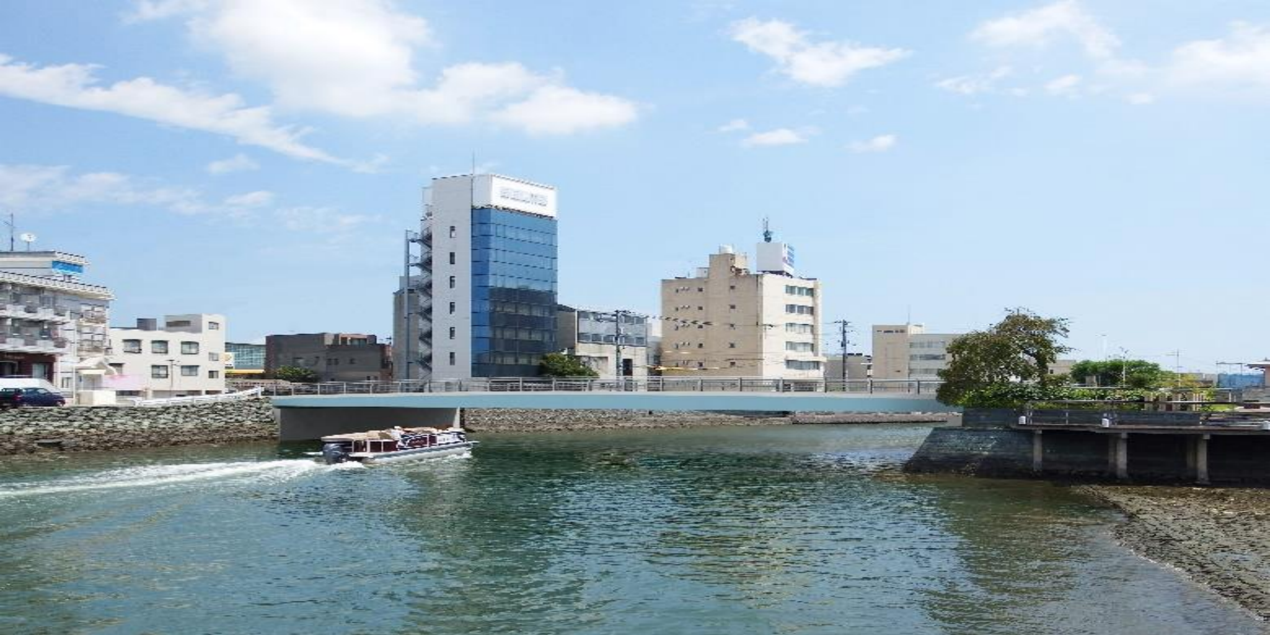
写真2 桁色：水色 高欄：銀色 上流側より
