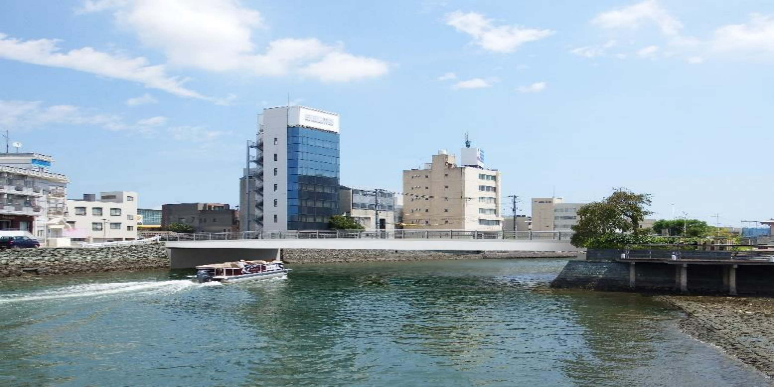
写真6 桁色：白色 高欄：銀色 上流側より
