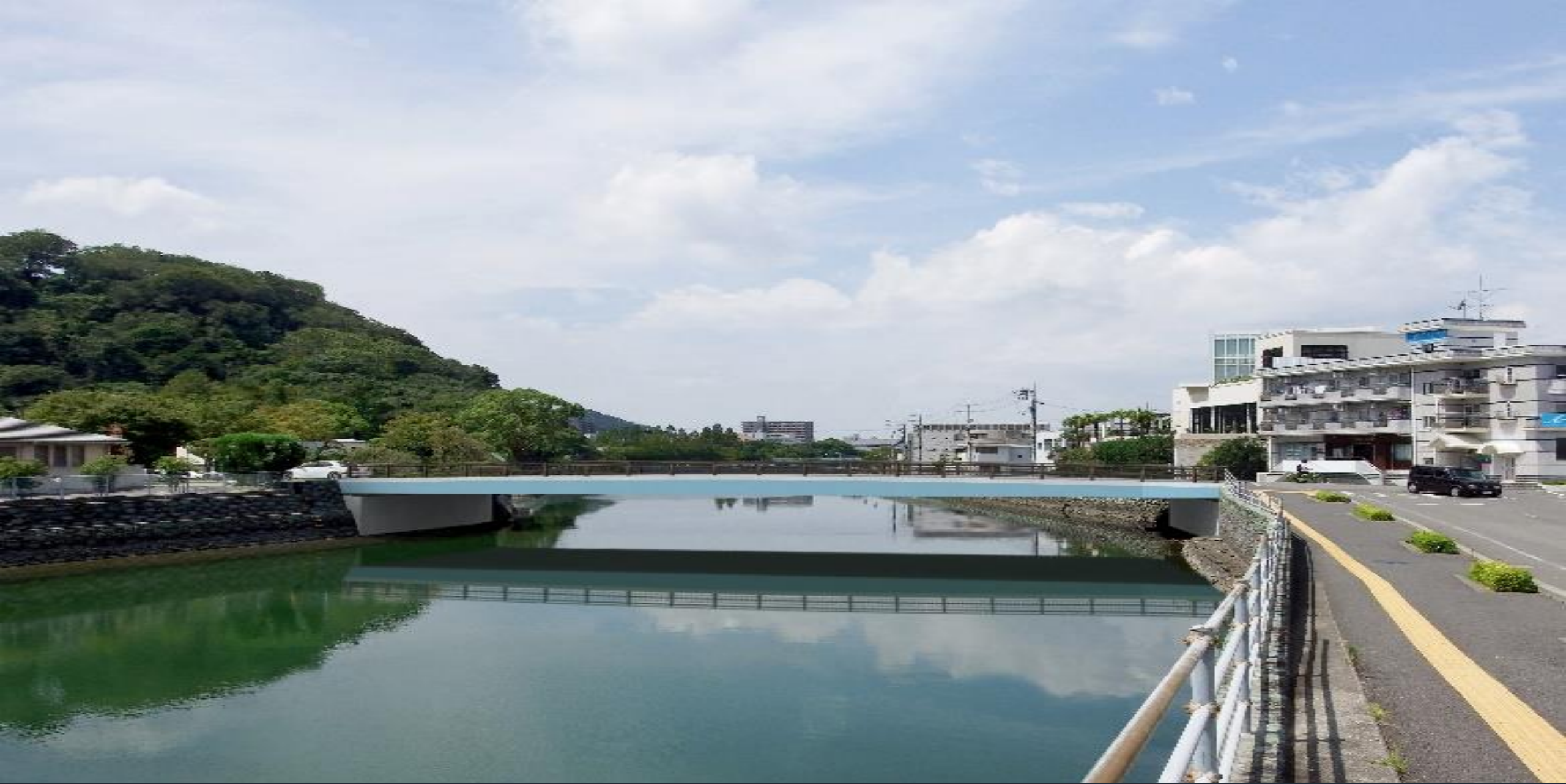
写真1 桁色：水色 高欄：茶色 下流側より
