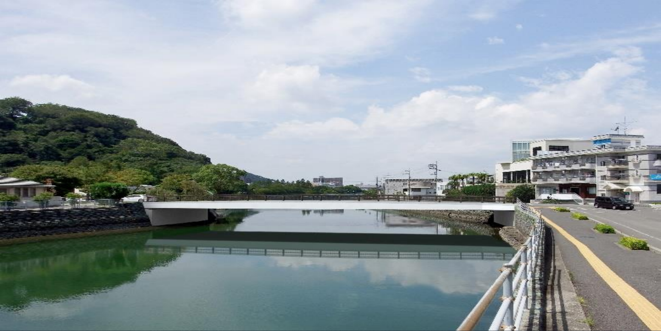
写真5 桁色：白色 高欄：茶色 下流側より
