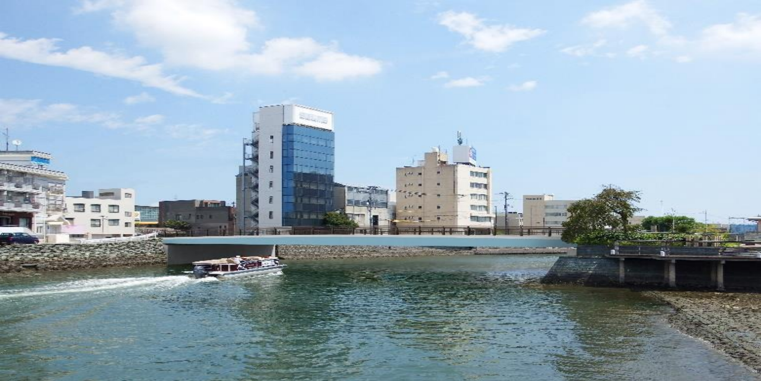
写真1 桁色：水色 高欄：茶色 上流側より
