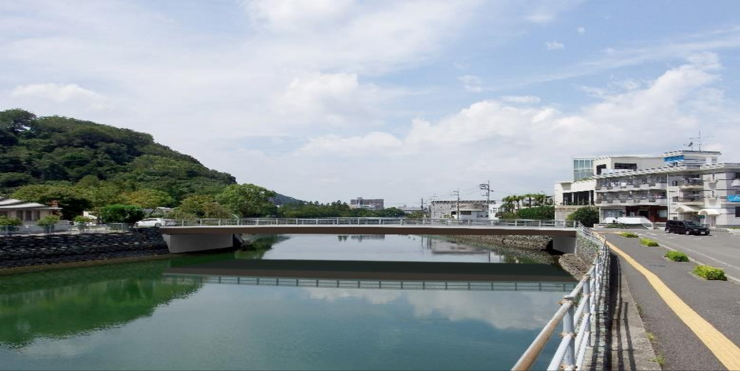
写真4 桁色：茶色 高欄：銀色 下流側より
