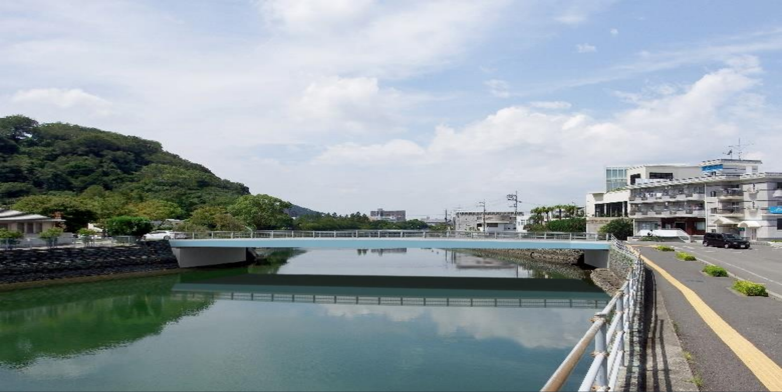
写真2 桁色：水色 高欄：銀色 下流側より
