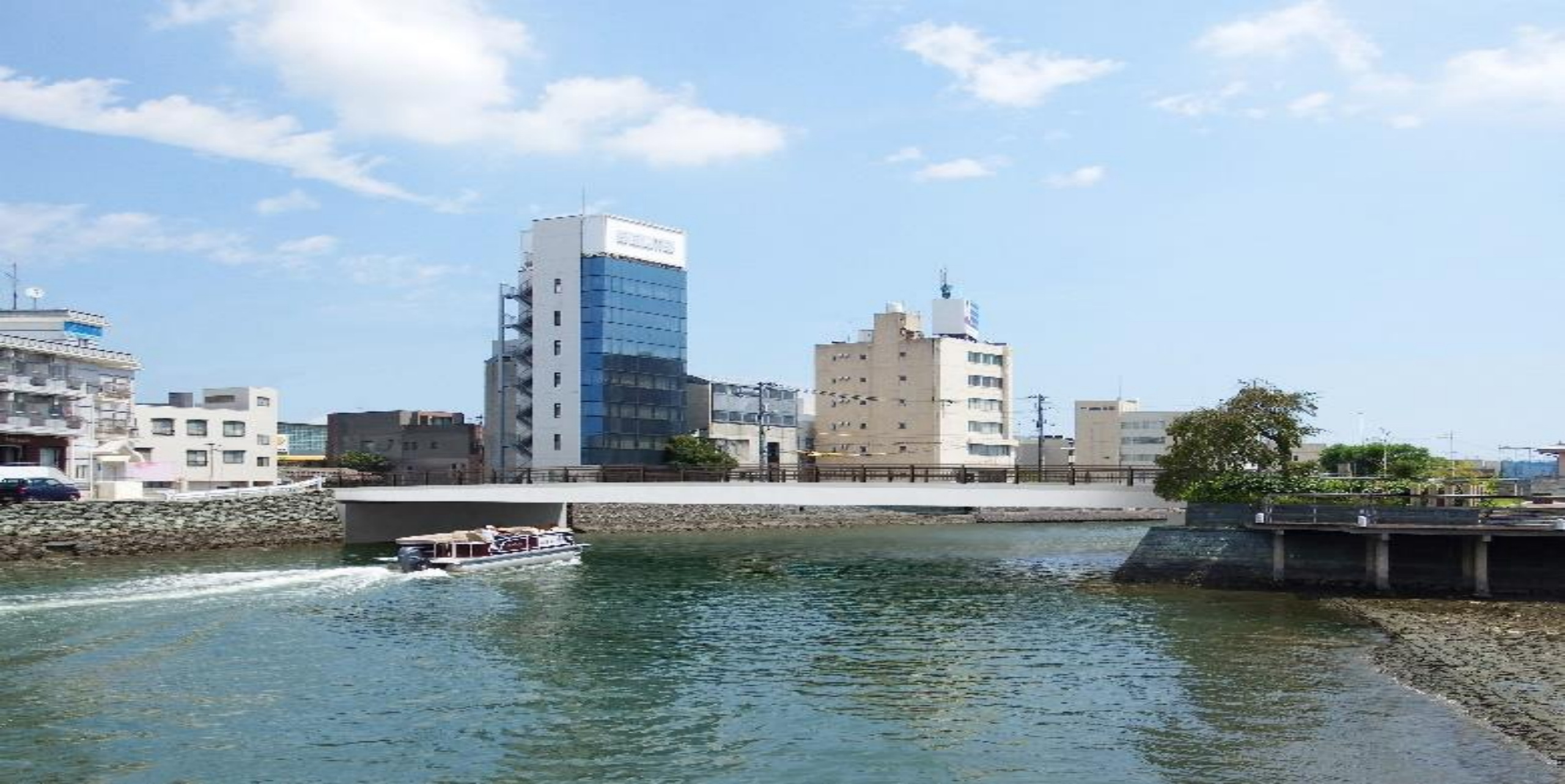
写真5 桁色：白色 高欄：茶色 上流側より
