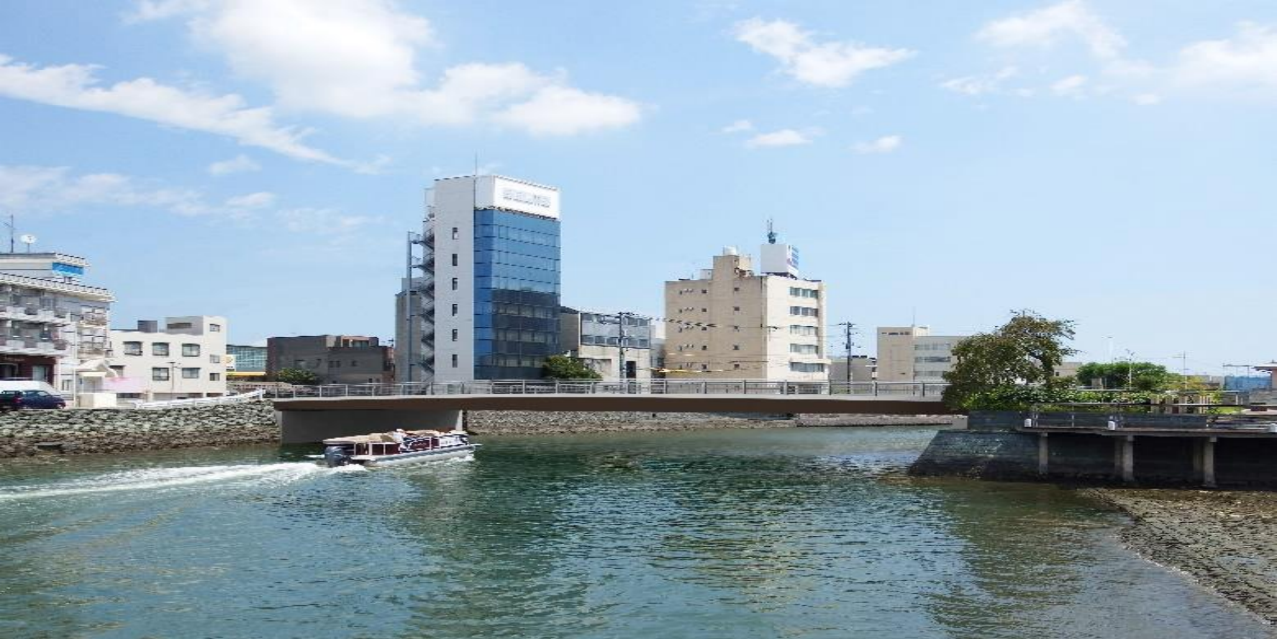
写真4 桁色：茶色 高欄：銀色 上流側より
