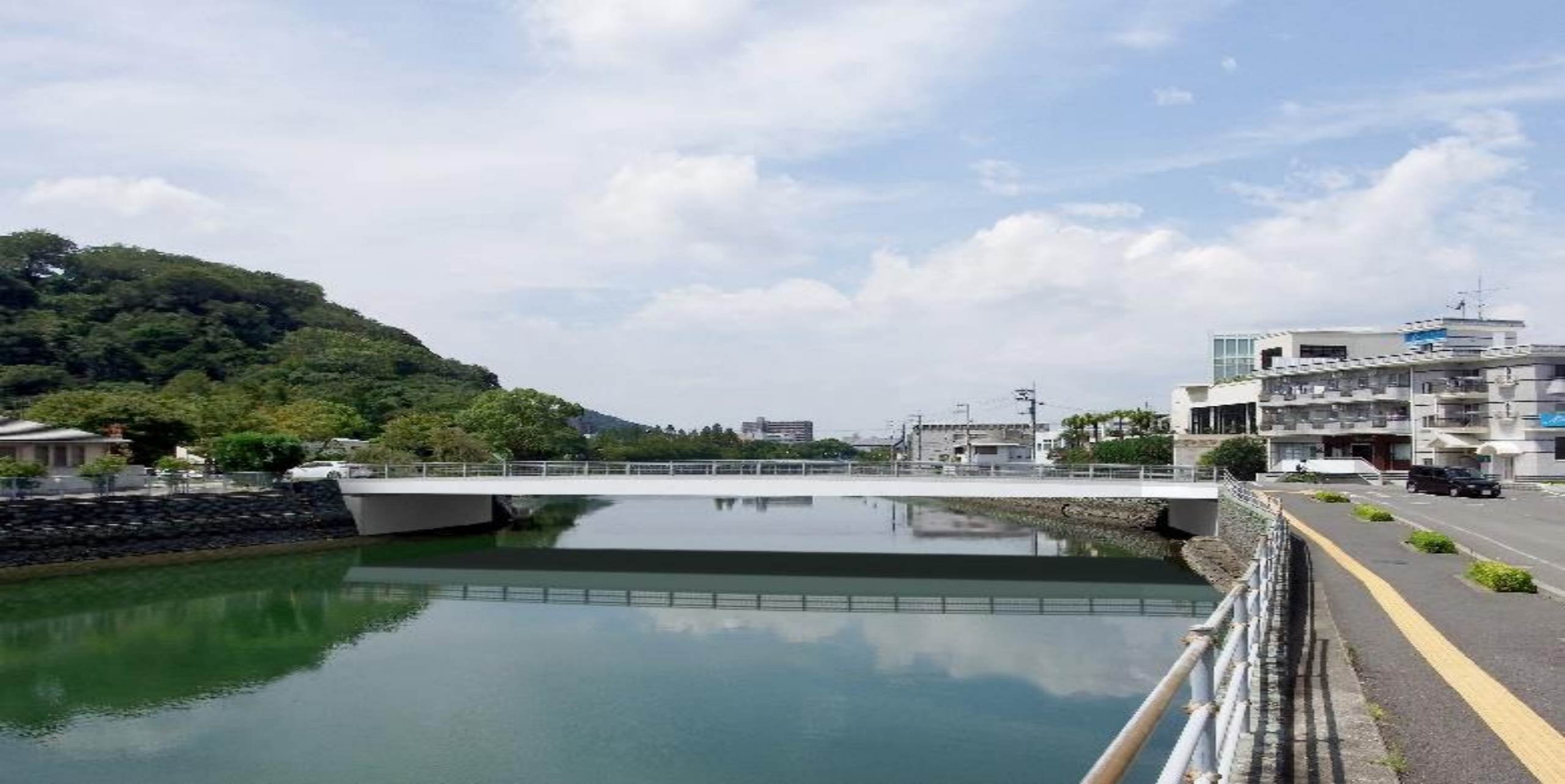
写真6 桁色：白色 高欄：銀色 下流側より
