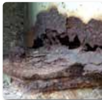
H桁橋の桁端部及び 支承の腐食
