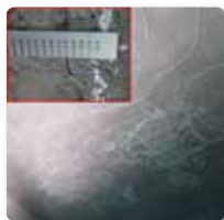
H桁橋の桁端部及び 支承の腐食
