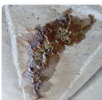
PC桁下面の錆汁を伴う漏水・遊離石灰、ひびわれ、浮き
