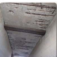
RC床版下面前面に浮き、剥離・鉄筋露出
