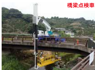
遠望目視では橋脚上の桁端部は死角
