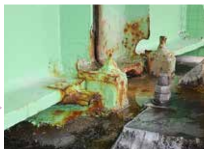
近接目視で橋脚上の桁端部の損傷発見
