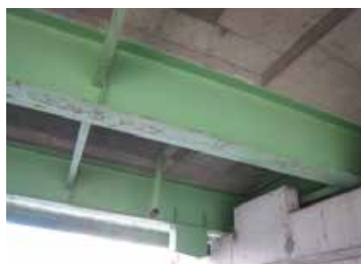
遠望目視では橋脚上の桁端部は死角
