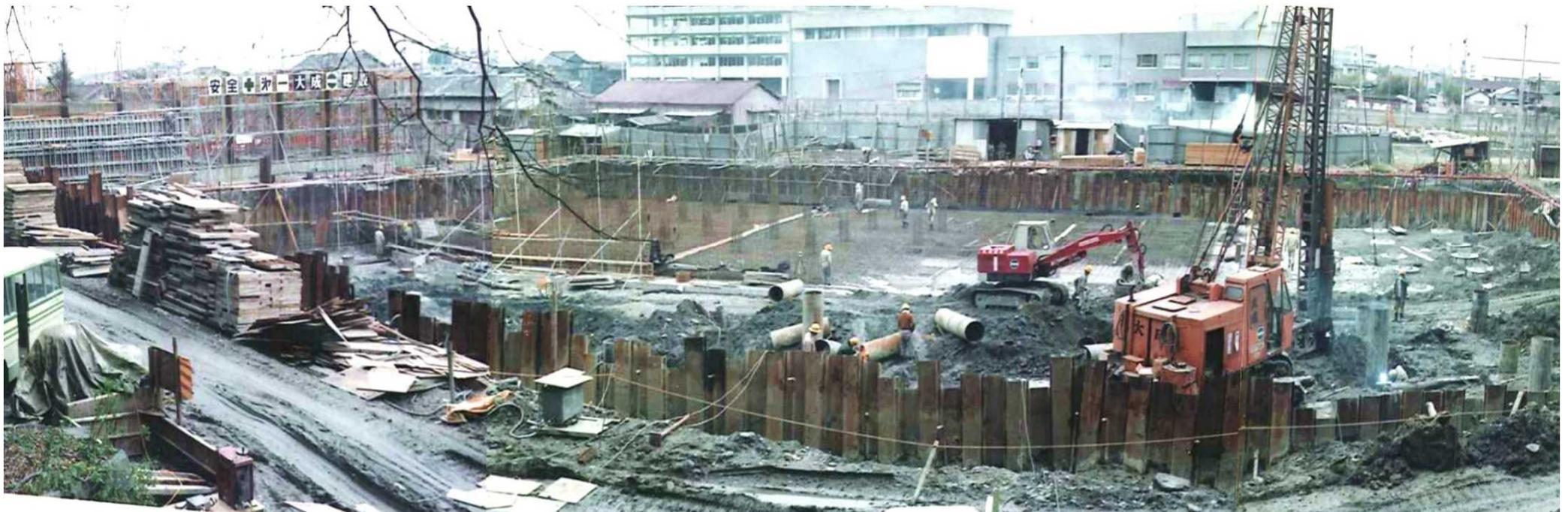
1971年11月25日 西の丸配水場調整池建設状況(配筋工・基礎杭工) 対岸に旧NHK徳島放送局 郵政省貯金局
