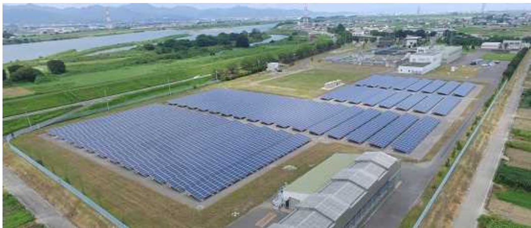
図7 太陽光発電設備（第十浄水場）
