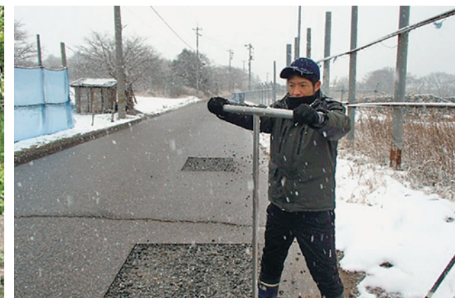
水道工事（切り替え作業）
