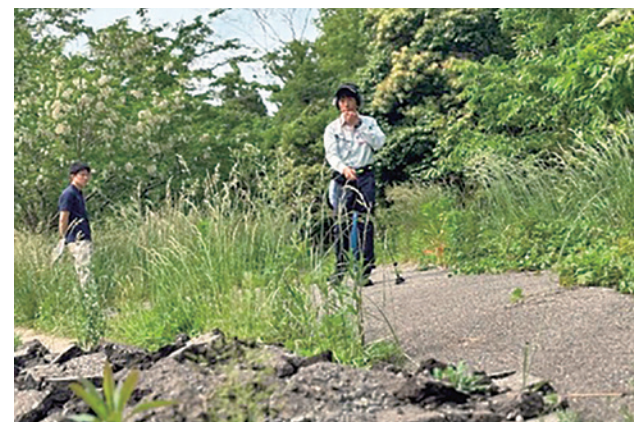
漏水調査（路面音聴調査）
