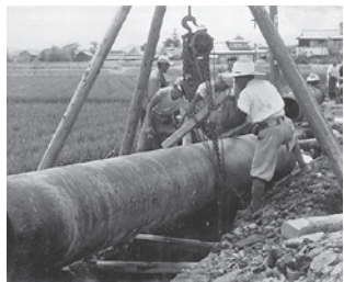
西の丸送水管新設工事
