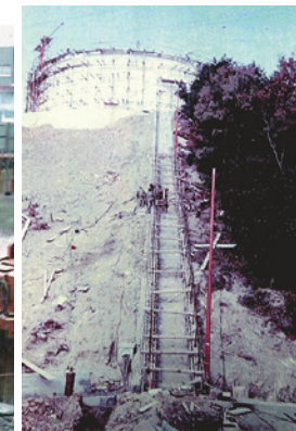
法花谷配水池建設
