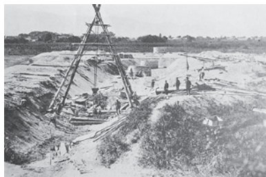
第十水源集水井工事
