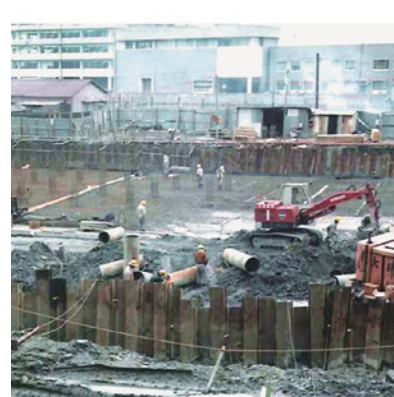
西の丸配水場調整池建設
