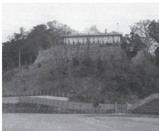
城山配水池完成 (昭和38年)
