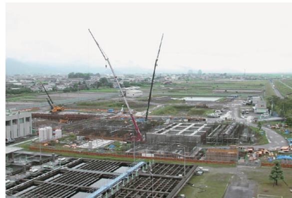
浄水施設建設工事
