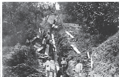
佐古山配水池
