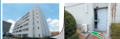
徳島地方合同庁舎（東側通入入口付近）
