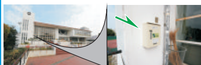
内町小学校（正面玄関入口付近）
