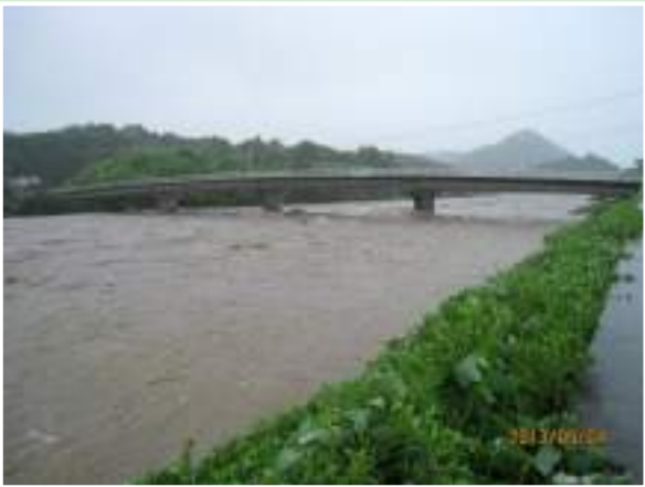
洪水時の鮎喰川(入田春日橋)
