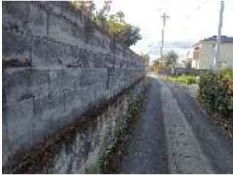
擁壁上のブロック塀
