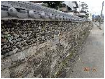
石積み塀・石垣塀
