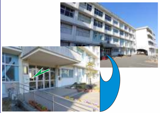
川内中学校（南校舎正面玄関）
