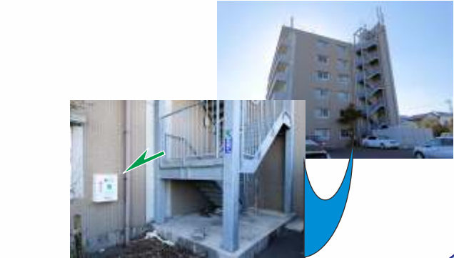
スペースドゥ川内（北側屋外階段付近）
