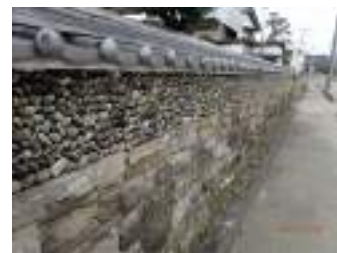
石積み塀・石垣塀
