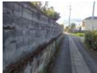
擁壁上のブロック塀
