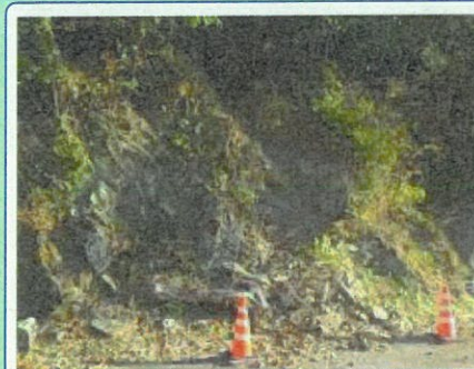
県道212号線飯谷小学校～日浦橋の区間は崩壊防止工がほとんどない。
