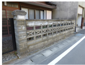
飾りブロックが多用されたブロック塀
