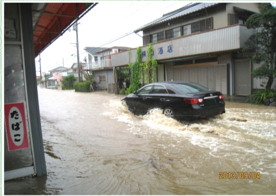
道路冠水(郵便局～駐在所間)
