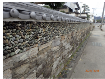
石積み塀・石垣塀
