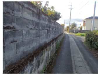
擁壁上のブロック塀
