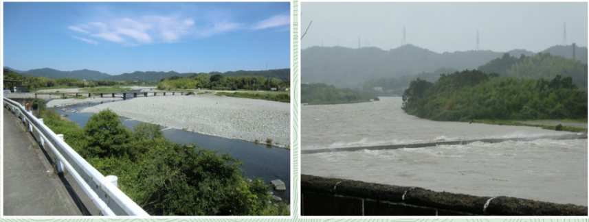
梁瀬橋 (左：平常時、右：洪水時)
