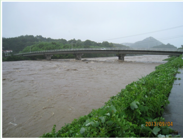
洪水時の鮎喰川(入田春日橋)
