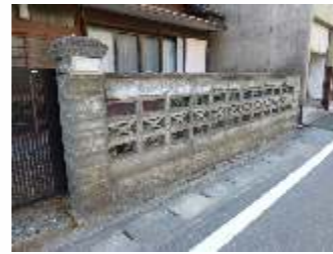
飾りブロックが多用されたブロック塀
