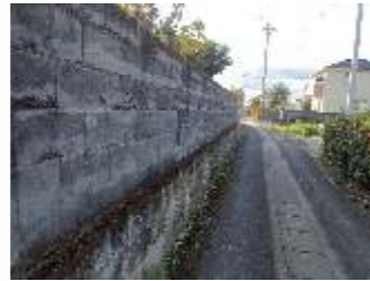
擁壁上のブロック塀
