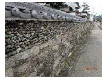
石積み塀・石垣塀
