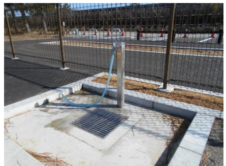
【水飲み場兼足洗い場】
