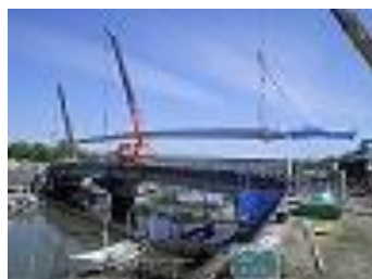
橋りょう添架管架替工事
