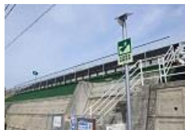
津波避難施設
