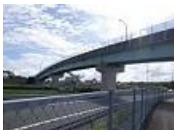
橋りょうの耐震補強
