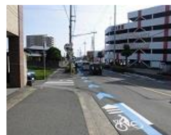
自転車走行空間整備
