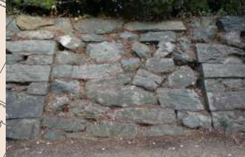
15 西の丸の石垣 香風台から隅櫓までの全長約150mの間に石垣が残る。写真は西の丸御殿と御花島を結ぶ通路をふさいだ石積み。
