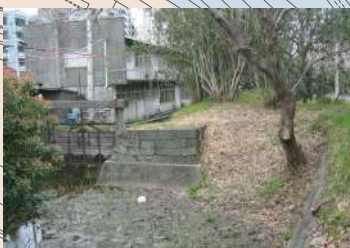
16 塩蔵門 塩や荷物などを寺島川沿いに船で運び、ここから荷揚げした。
