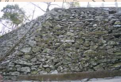
8 本丸北側の石垣 文禄～慶長期頃の石垣。加工した石材を使い始めている。算木積みもほぼ完成に近い。
