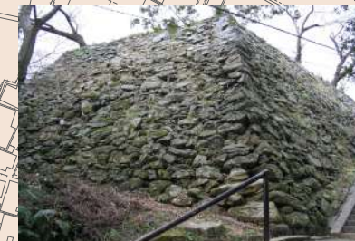
6 本丸東端の石垣 徳島城で最も古い天正期の石垣。自然石の野面積みが素晴らしい。
