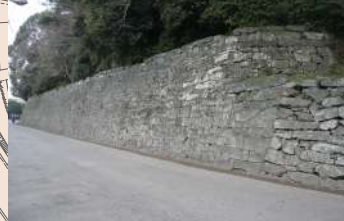
14 城山南西麓の石垣 天保14年(1843)の12代藩主斉昌の西の丸隠居屋敷造営時の頃に築かれた石垣と考えられている。切り込みハギによる布積みが美しい。
