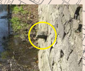
17 舌石 旧寺島川沿いの折れ曲がり堀(屏風堀)の柱を支えた台石。現在6カ所が残る。
