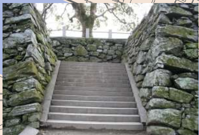
9 搦手門 本丸北側に位置し、御座敷の地下から場外(助任川)に通じていた埋門。
