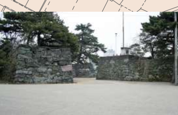
18 黒門(大手門)枅形 門の上部は弓櫓になっていた。石垣築石には「大」「太」「瓢箪」などの刻印がみられる。
