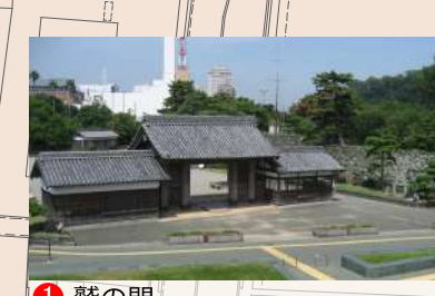
1 鷲の門 徳島城の表門で脇戸付の薬門。昭和20年(1945)に戦災で消失したが平成元年(1989)に復元された。
