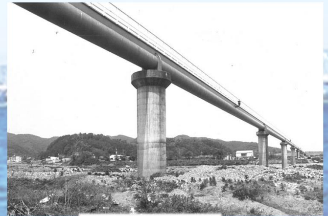
鮎喰橋水管橋
