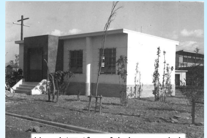
第3水源ポンプ室(1954年)
