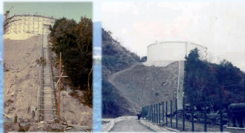
法花谷配水場建設工事(1974年)
