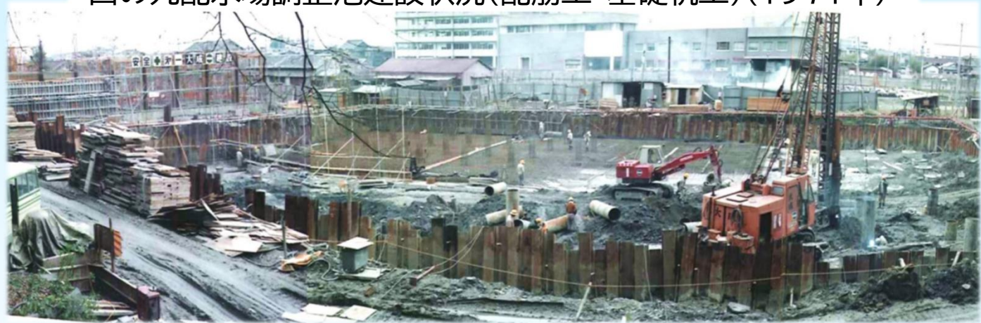
西の丸配水場調整池建設状況(配筋工・基礎杭工)(1971年)
