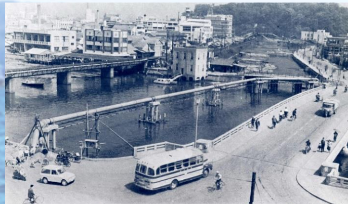
かちどき橋水管橋
