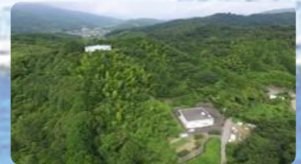
多家良配水場
