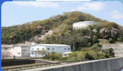
法花谷配水場
