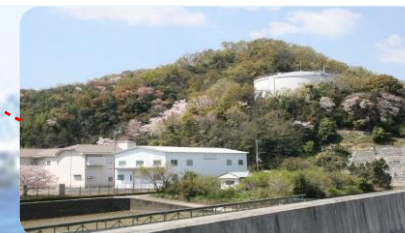
法花谷配水場 2,000m 3 (配水池・調整池)
