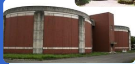
佐古山配水池
