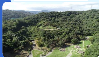
一宮配水場 1,320m 3 (高区)5,600m 3 (低区)
