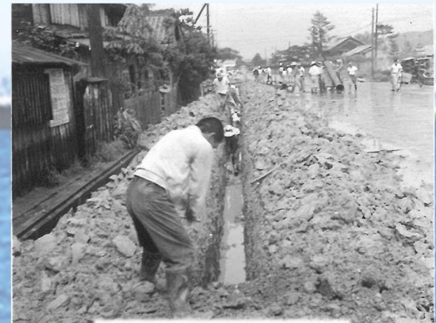
第3水源連絡管工事
