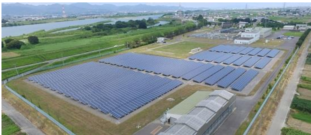
図7 太陽光発電設備（第十浄水場）
